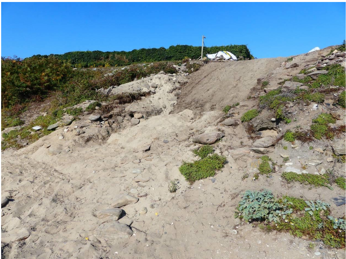
Fig. 25. Vue depuis le sud-est de la tranchée 1 après rebouchage (cliché C. Nicolas).
