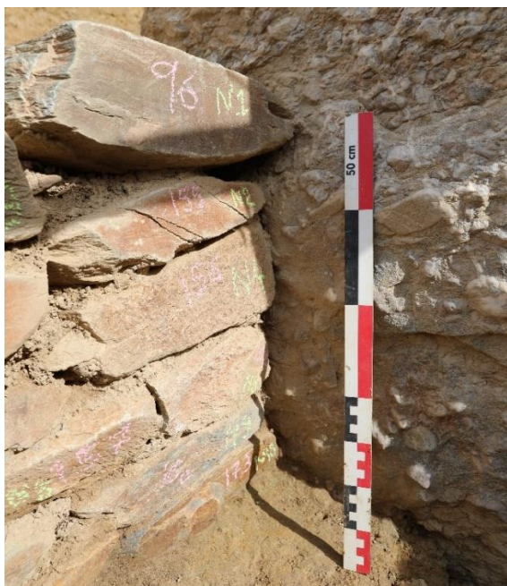
Fig. 72 – Vue de la jonction entre le parement nord et la dalle de poudingue F52, formant la paroi est. Les moellons sont parfaitement ajustés contre la dalle (cliché C. Nicolas).
