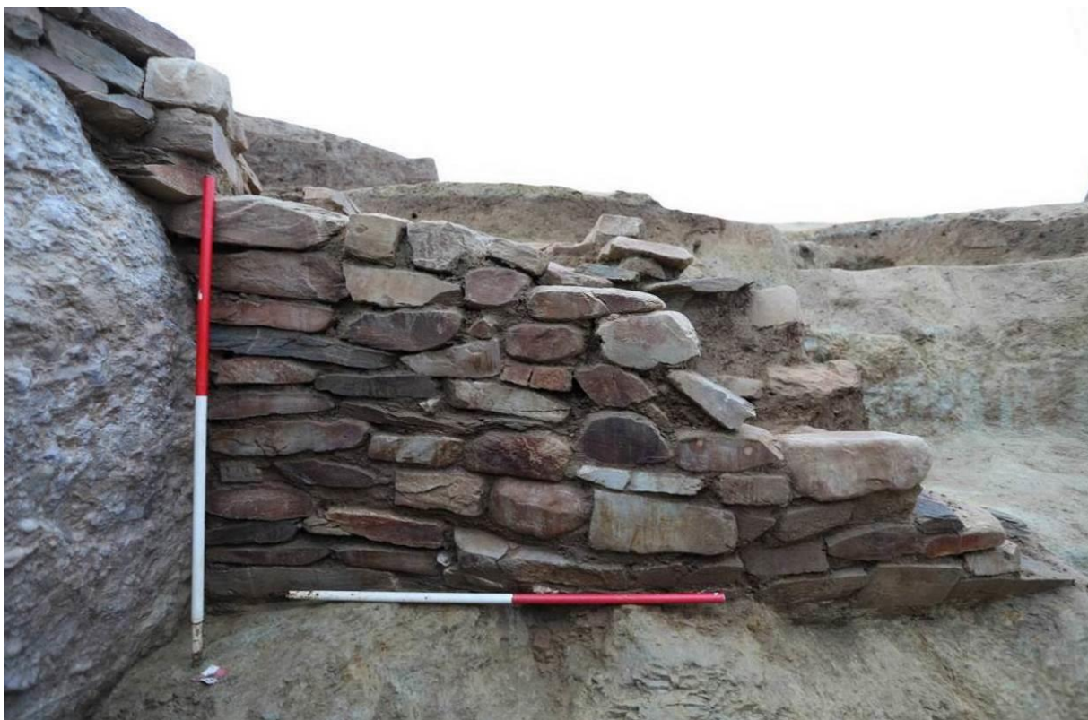
Fig. 58 – Vue du parement nord (cliché C. Nicolas).
